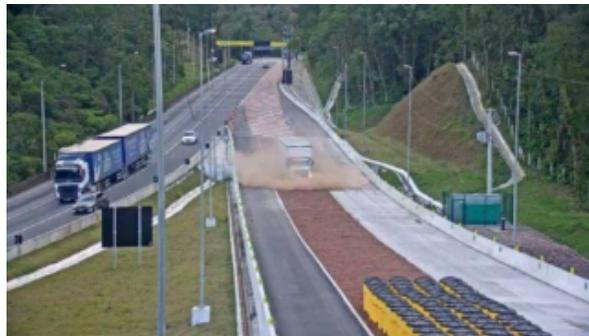
Considere que o caminhão durante a frenagem se comporta como um bloco de igual massa e velocidade que desliza em um plano inclinado para fazer suas estimativas. O início da área de escape é a parte de baixo de um plano inclinado de um ângulo  $\theta = 30^\circ$  em relação à horizontal. Se o caminhão entra na área de escape com velocidade de 108 km/h e para depois de percorrer uma distância de 75 m, o coeficiente de atrito cinético entre o caminhão e o piso é de aproximadamente:
